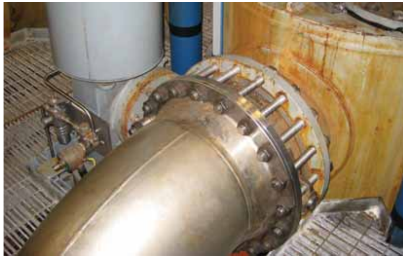
Abb. 6.22: Salzwasser ist eine der korrosivsten Flüssigkeiten, der nichtrostender Stahl ausgesetzt sein kann. Das Risiko einer Spaltkorrosion ist besonders hoch und kann nur durch Verwendung von sogenannten Superlegierungen ausgeschaltet werden. Dieses Kühlwassersystem einer Bohrplattform im dänischen Teil der Nordsee wurde aus 4547 (254 SMO) hergestellt. Foto: © Maersk Oil.
