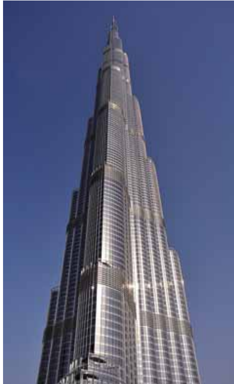
Abbildung 0.3: Mit seinen 828 Metern und 162 Stockwerken ist der Burj Khalifa in Dubai das höchste Gebäude der Welt und gleichzeitig eine der beeindruckendsten Konstruktionen auf diesem Planeten. Zum Schutz vor dem Meersalz bestehen große Teile des Gebäudes aus säurebeständigem, nichtrostenden Stahl der Sorte 4404.
